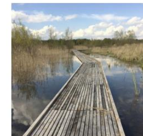
Boardwalks i vådområdet ved KANTEN
