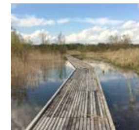
Boardwalks i vådområde ved KANTEN
