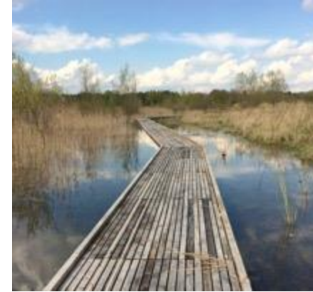
Boardwalks i vådområde ved KANTEN
