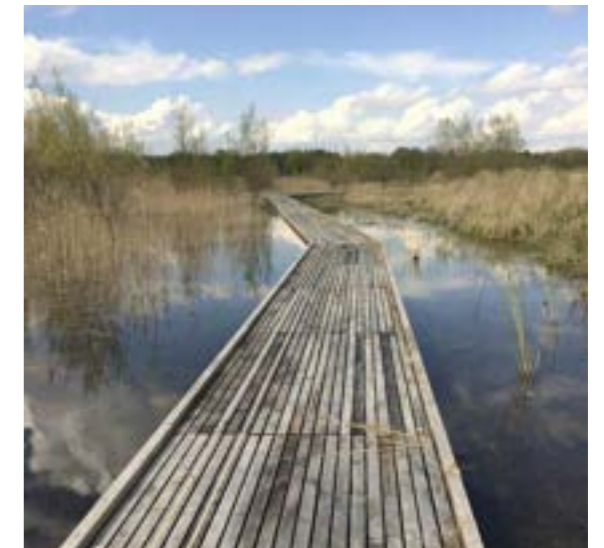
Boardwalks i vådområdeet ved KANTEN
